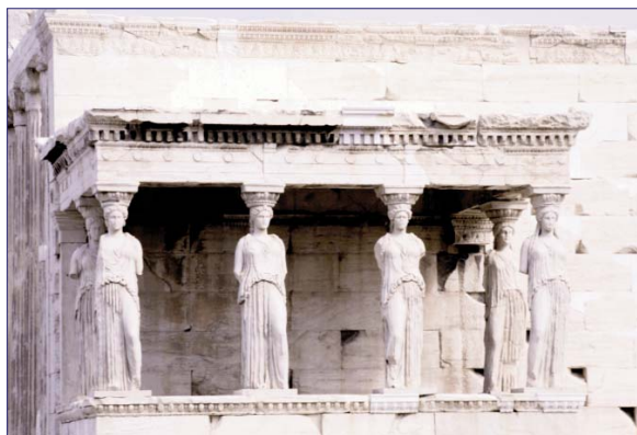
Cariátides del Erecteion. Acrópolis de Atenas, s. V a. C. (ISFTIC. Banco de imágenes)
